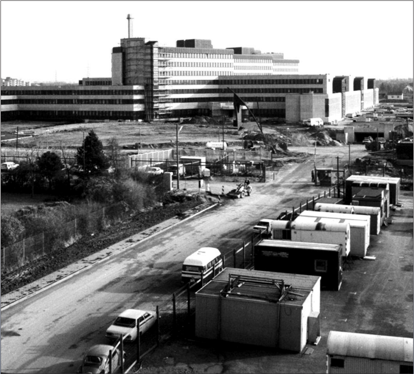
Die aktuelle Liegenschaft des BFV in Köln während der Bauphase.
